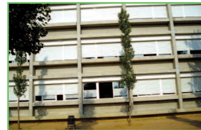
FOTO: Panoràmica de la paret on hi ha la major part de les aules, amb totes les persianes tancades, ja que la llum del sol reflecteix sobre les pissarres, un dia del passat mes de setembre a les 10 del matí. L'única finestra oberta de bat a bat ja té instal·lada una banda translúcida.
